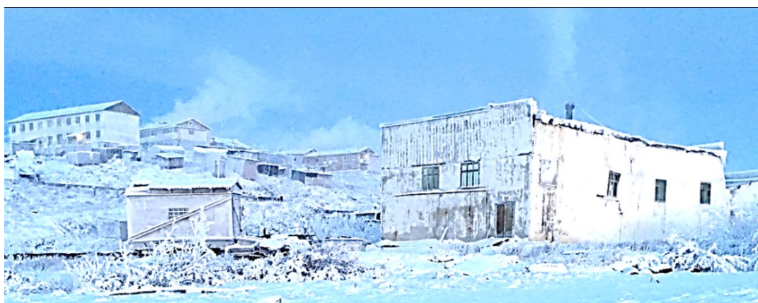
Рис. 2. Функционирующие очистные сооружения канализации поселка Чокурдах Fig.2. Functioning sewage treatment constructions in Chokurdakh village
